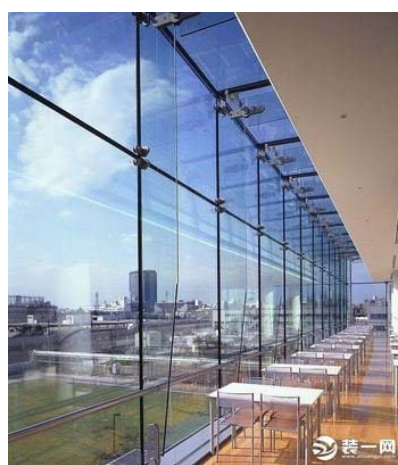
图二 民建玻璃幕墙
